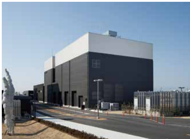
エネルギー棟
