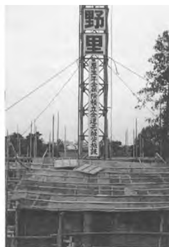
工事進捗状況（昭三五・四・一現在）
