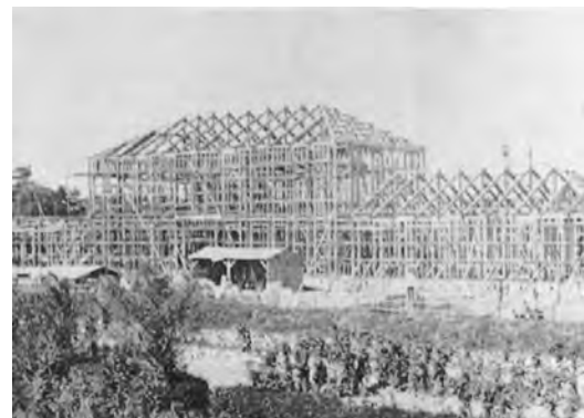
〈正面（南側）より撮影した建築風景〉
