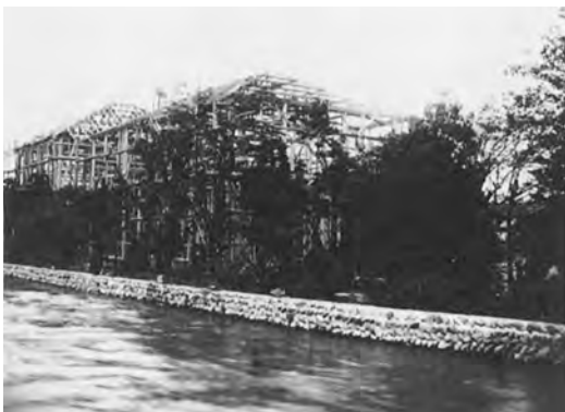
〈北側から撮影した建築現場〉
